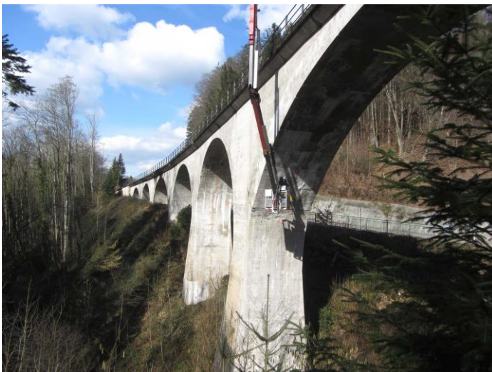
Von einer mobilen Arbeitsbühne unterhalb des Laufenmühle-Viadukts wurden detaillierte Zustandsaufnahmen per Radar und Ultraschall durchgeführt. (Bild IONYS/KIT)
